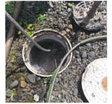
▲排水マス洗浄例
